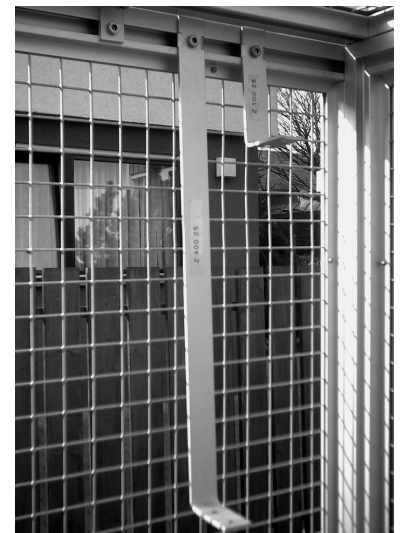
Bild zeigt: Volieren-Innenseite mit dem Dach-Seitenwand-Verbinder (Z3030) und Sitzstangenhalter am oberen Systemholmen.
