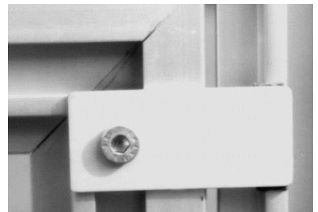
Türanschläge: Pro Tür 2 Stück erforderlich. Bauteil-Nr. Z9025
